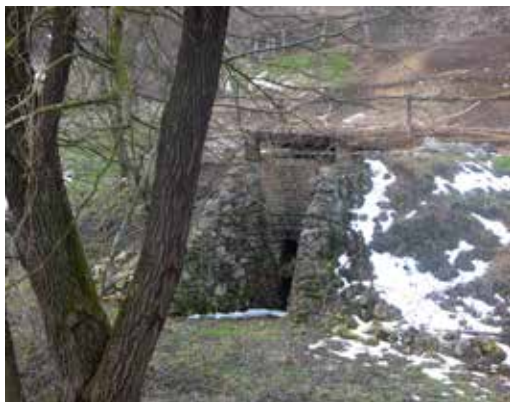
Velika krečana ukopana u obalu mjesnog potoka, Srednji Lipovac, ožujak 2010.
