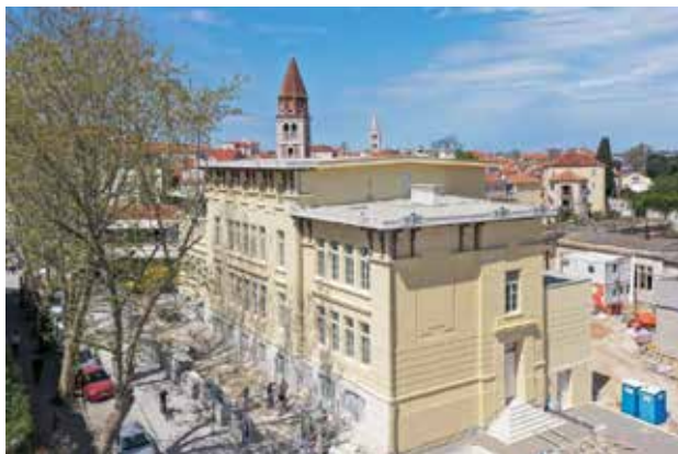
Obnovljena zgrada Škole za umjetnost i obrt – novi prostori Sveučilišta u Zadru 2023. godine
