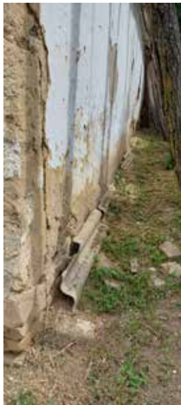
Fotografija gatora koji će se obnavljati starim tehnikama, srpanj 2023.
